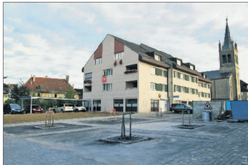
Les travaux de construction de la nouvelle place du Temple arrivent à leur terme.
