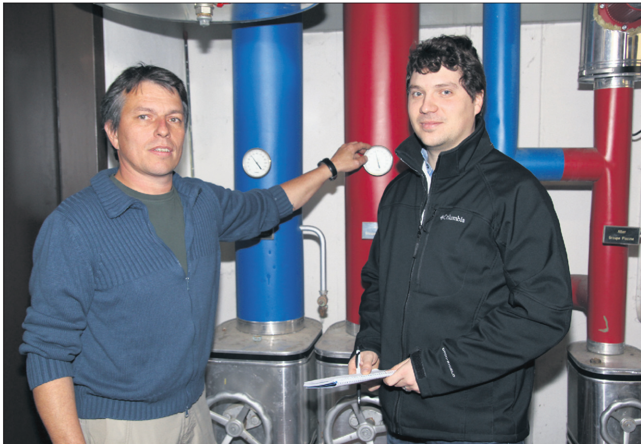
Olivier Despont, chef d'exploitation des bâtiments communaux, et David Gremaud, consultant en énergie chez Enerplan.
